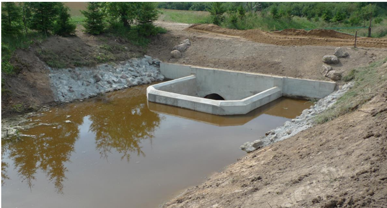
Pav: Viena iš vandens lygi Amalvos pelkės šiauriniame ir vakariniame pakraščiuose palaikančių slenksčių.
